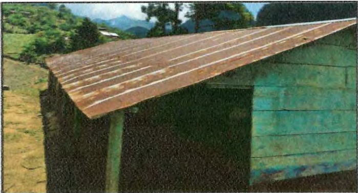
Foto1: SUSTITUCION DE ENTECHADO DE AULAS
